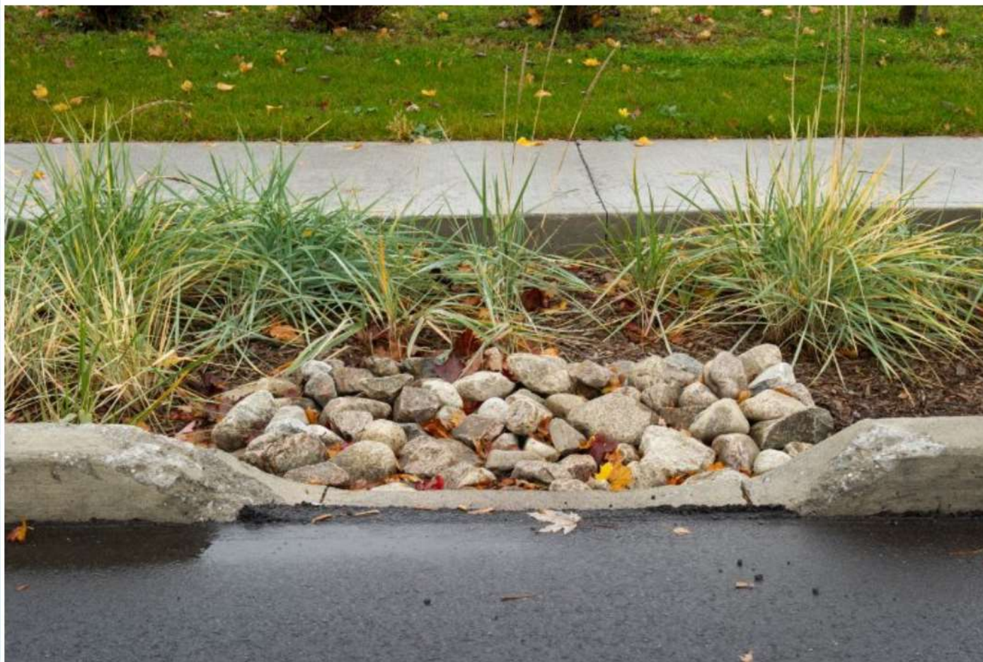
Un îlot de biorétention de la rue Saint-Amant. Crédit photo: Ghyslain Bergeron
