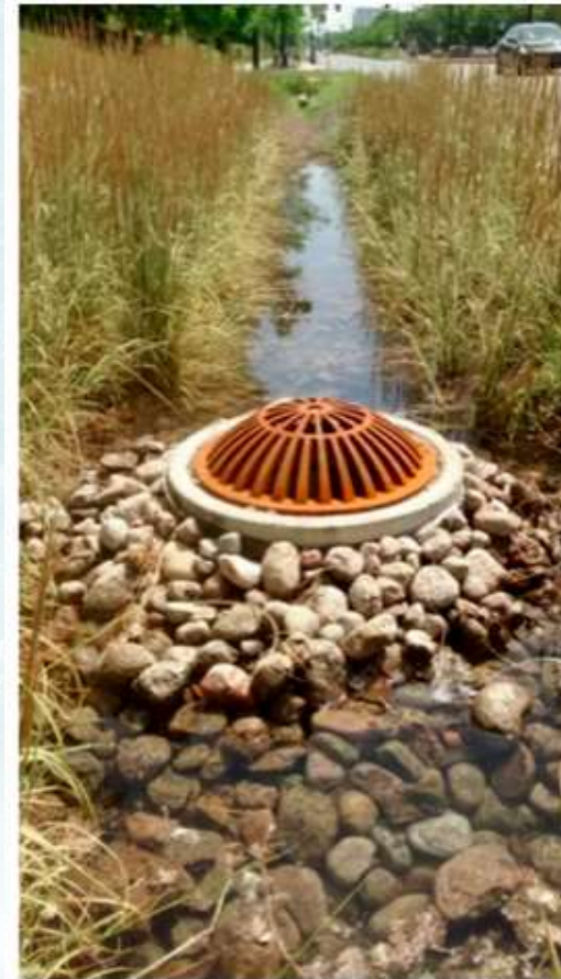
Trop-plein d'eau – Bassin de biorétention situé sur l'avenue Papineau, entre la rue Louvain et la rue Barnabé Larocque, à la limite du district Saint-Sulpice (Source: Ville de Montréal )
